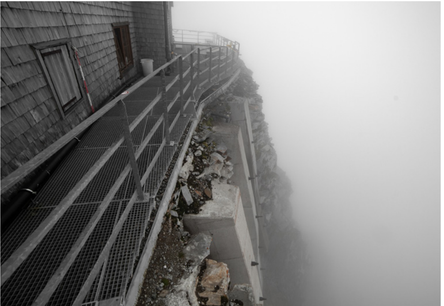
Das Observatorium am Hohen Sonnblick musste aufgrund auftauender Permafrostböden zusätzlich gesichert werden. Sommer 2019 © Greenpeace / Mitja Kobal
