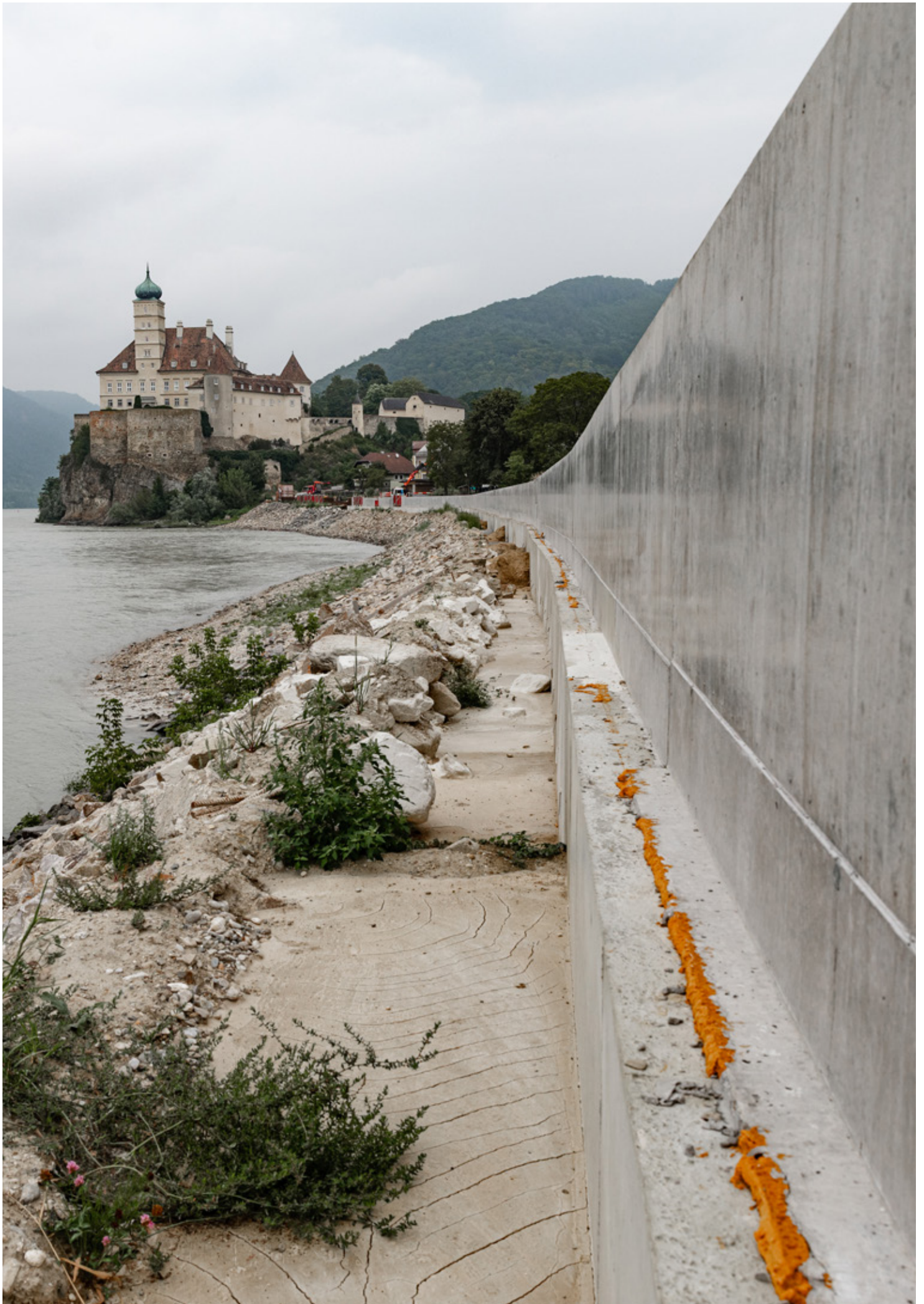
Aufgrund der steigenden Hochwassergefahr entlang der Donau werden Schutzanlagen errichtet. Sommer 2019 © Greenpeace / Mitja Kobal
